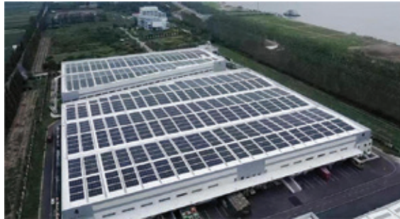
圖：漢南捷悅行光伏發電項目
